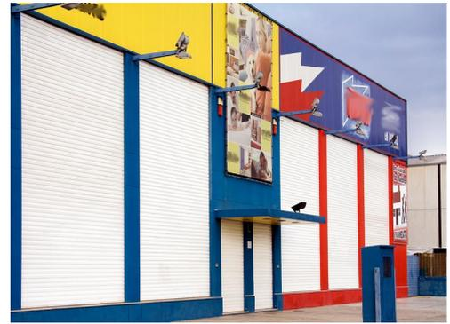
*Fabricada con lamas construidas por dos perfiles de aluminio lacado, separados con PVC para evitar la transferencia térmica, y luego, en su interior, inyectadas con poliuretano expandido.*
